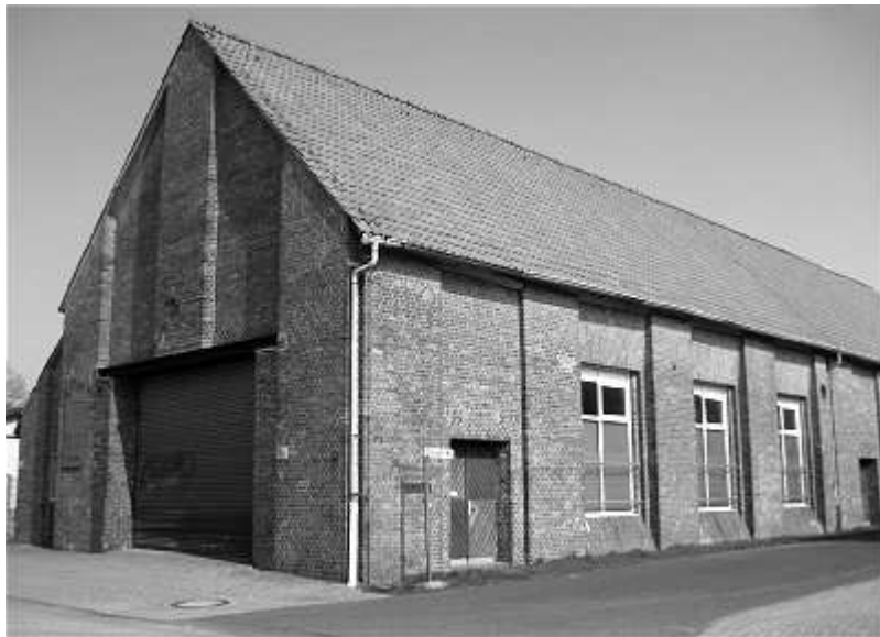
Steht noch heute an der Straße „Am Gaswerk“: Die alte Kompressorenhalle des Gaswerkes
